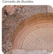
...**calizas y tobas** fueron perfiladas de forma más o menor regular para ser integradas en los muros por ser el material más abundante en La Bureba. La ligereza de la toba la hacía idónea para atenuar el peso de las bóvedas y, como curiosidad, se puede observar en forma de fósiles la huella de múltiples formas de vida que poblaron esta cuenca sedimentaria.
